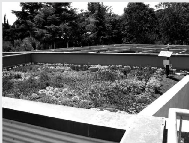
PHOTO 4 : Expérimentation de diversification végétale sur toiture végétalisée (crédit photographique : Plante & Cité).
