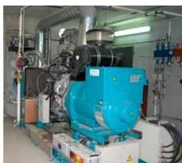
**FIGURE 4 – Co-générateur Dual-Fuel du GAEC Beets** (source : Chambre d'Agriculture du Loiret).
